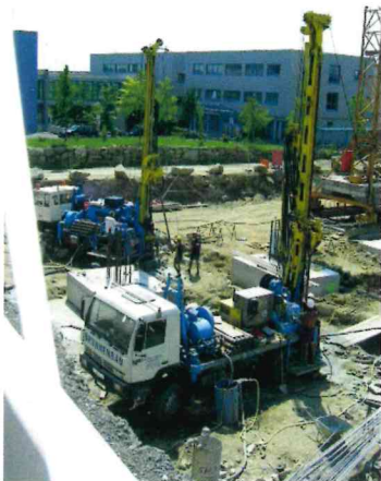
Bild 4: Tiefensondenbohrung © VÖBU
